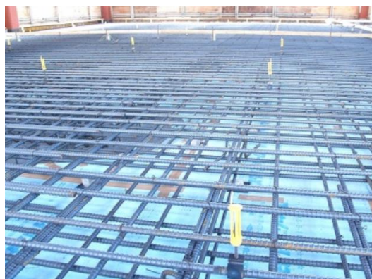
写真 3.1 レベルマーカの設置状況※web より
